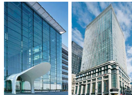
セイコーエプソン広丘事業所イノベーションセンター A棟 / 長野県 (2005)
