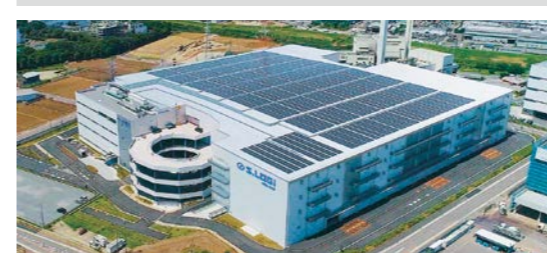
エスロジ新座W棟 / 埼玉県 (2019)
