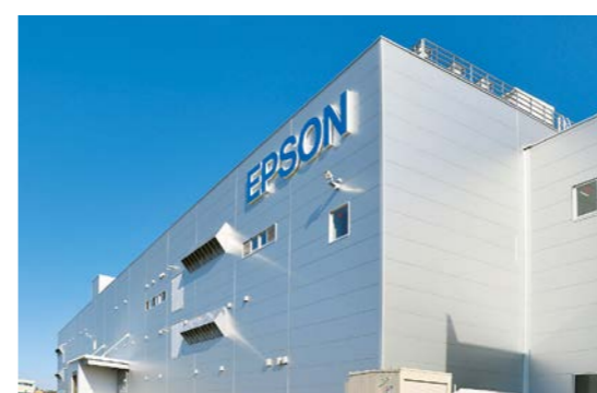
秋田エプソン7号棟 (写真: 大木建設(株)) / 秋田県 (2016)
