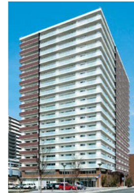
MJRザ千早 (撮影: 株エスエス) / 福岡県 (2010)
